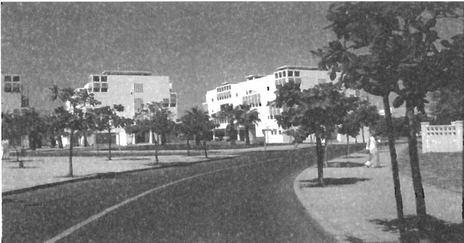
شكل ٨ : قوة تصميم كتل المباني السكنية كما يبرزها النمط الانحنائي، كما يبدو تأثرها بالخصوصية في واجهاتها.
